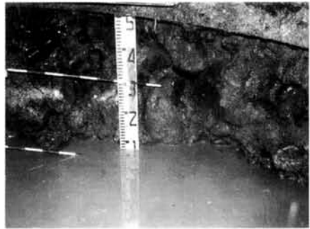
写真-7 立坑掘削状況
