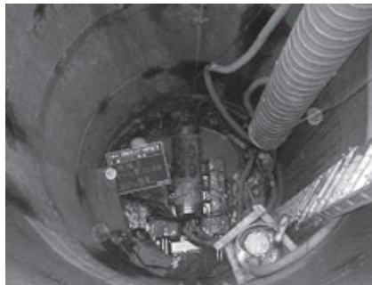
写真-2 土被り11mを越える深い立坑
