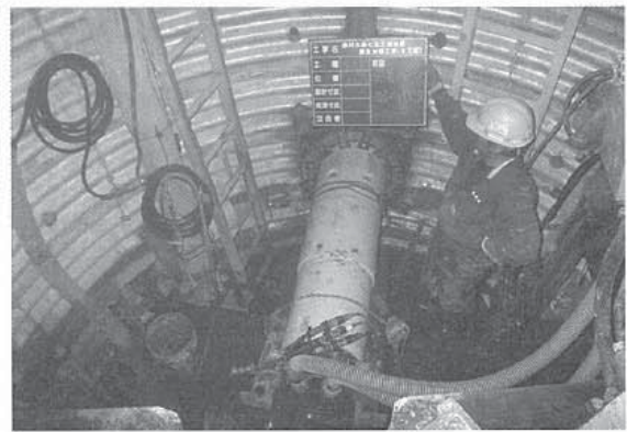
写真-4 ロックマンエース推進状況
